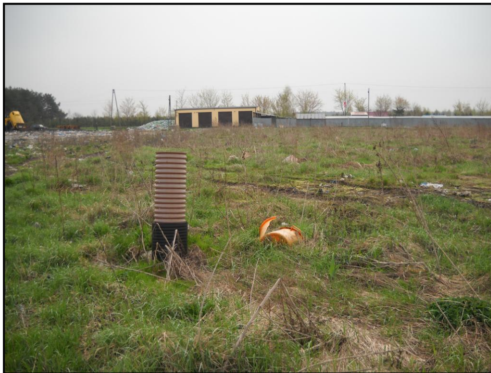
Fotografia nr 1. Istniejąca studzienka odgazowująca (16 kwietnia 2010r)
