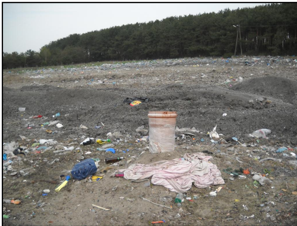
Fotografia nr 2. Istniejąca studzienka odgazowująca (16 kwietnia 2010r).
